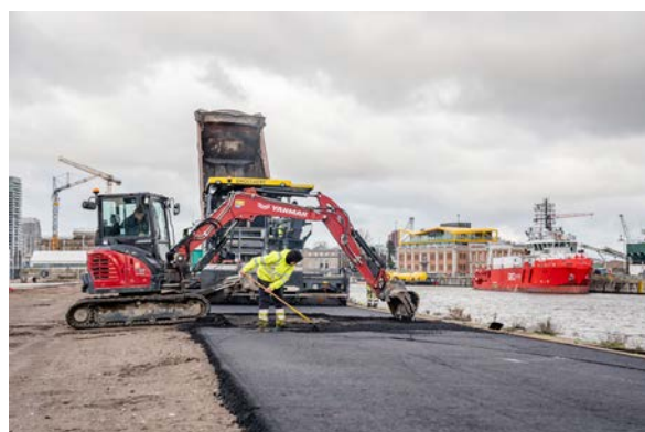
Foto 26 en 27: Tijdens werken Vlotdok-terminal
