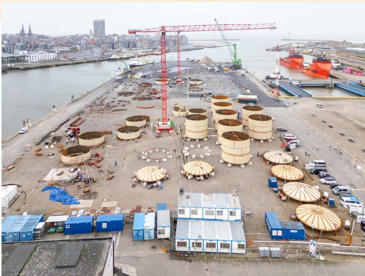
Foto 9: Opbouw van opslagtanks op de REBO-terminal
