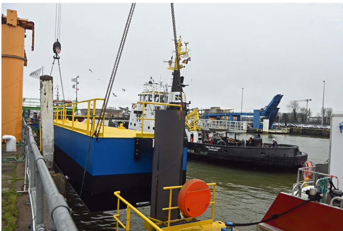
Foto 16: Tewaterlating nieuw ponton door MultiTech
