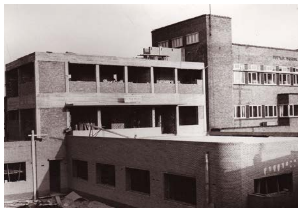
Foto 65: Westelijke uitbreiding van de Zeewaartschool
