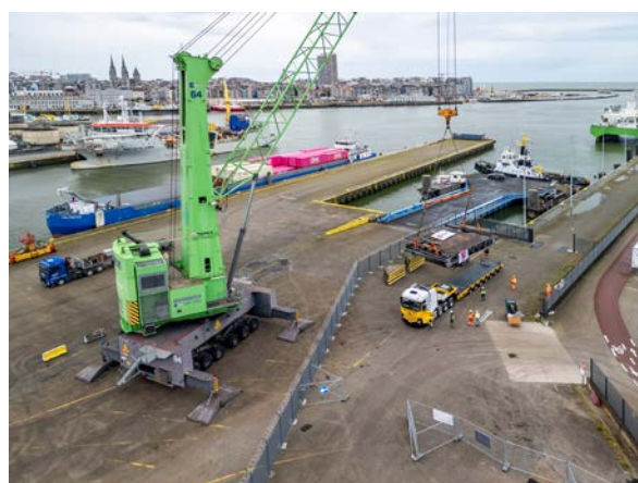
Foto 13: Behandelen van sluisdeur door OSSCO
